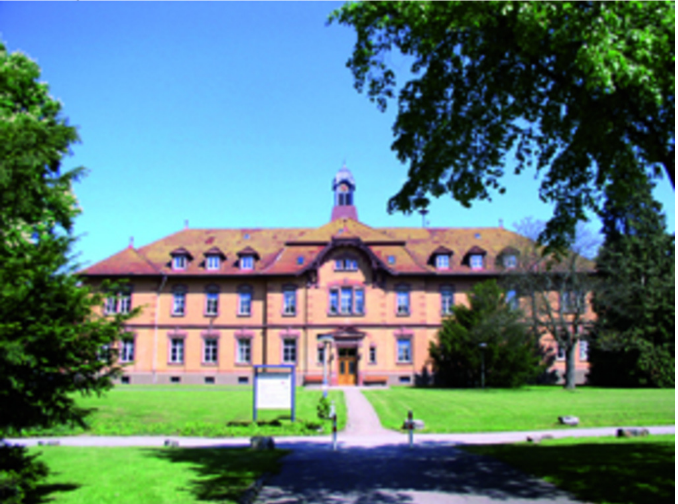
Abbildung: Abbildung: Klinikum am Weissenhof, historisches Verwaltungsgebäude von der Südseite
