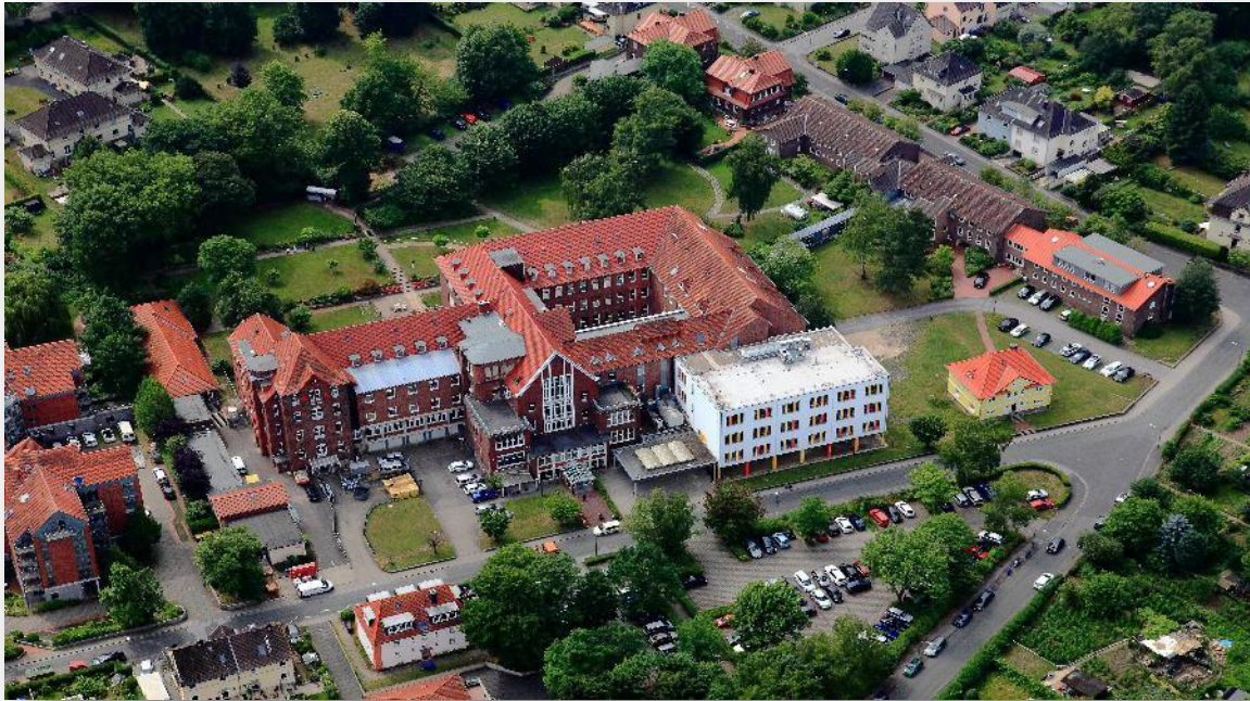
Luftaufnahme des Hüttenhospitals 2017
