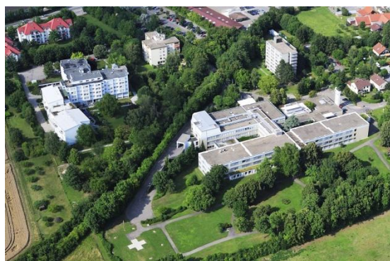
Abbildung 2 Krankenhaus Brackenheim/ Geriatrische Rehabilitationsklinik Brackenheim
